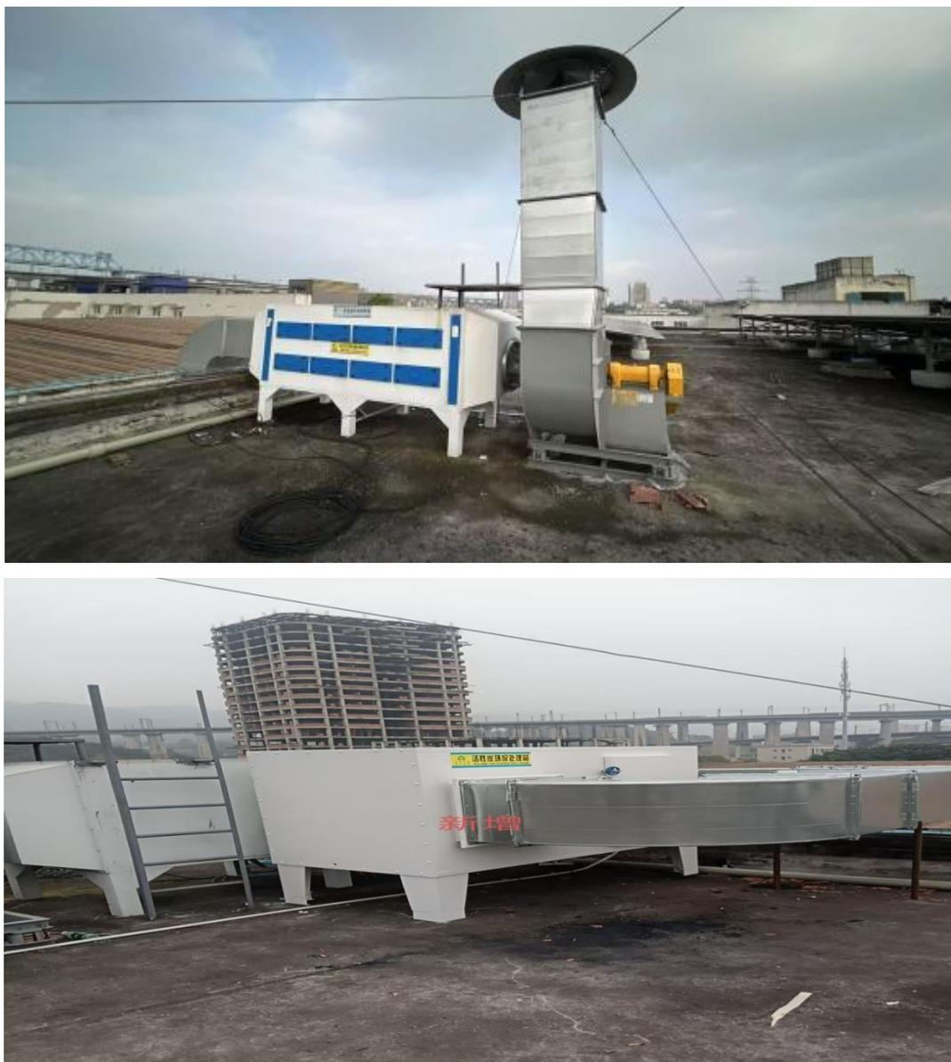
图 4-3 注塑废气净化处理系统
